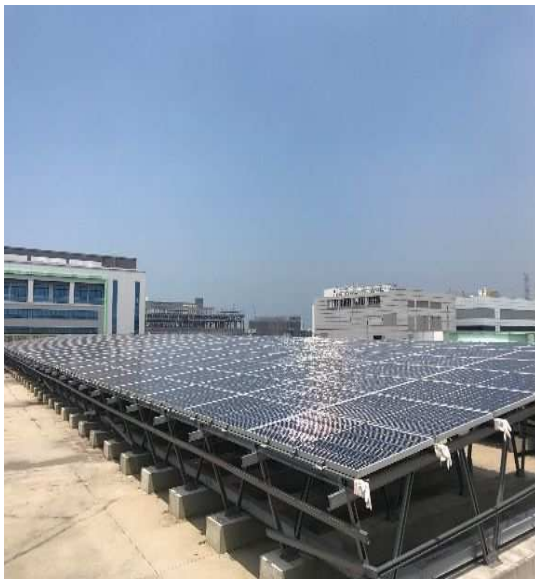
屋頂太陽能發電設備照片
